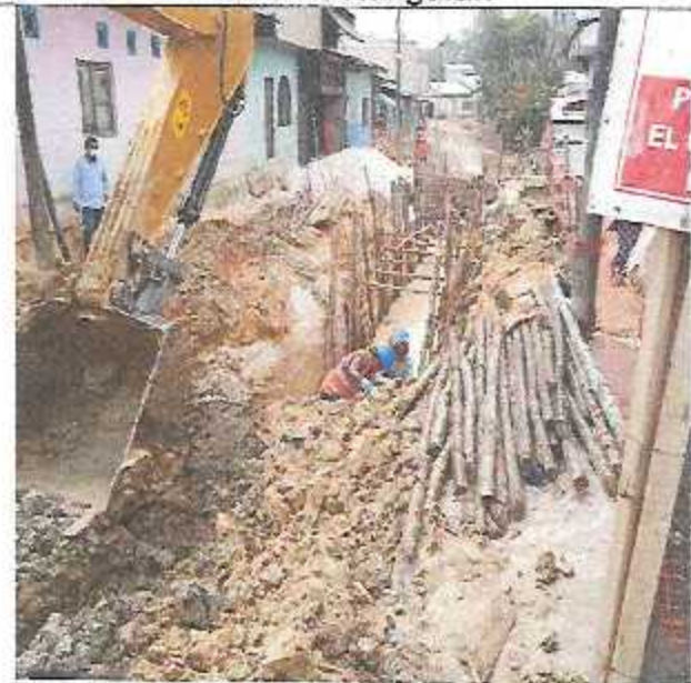
Cama de arena y llenado de solado para canal rectangular.
