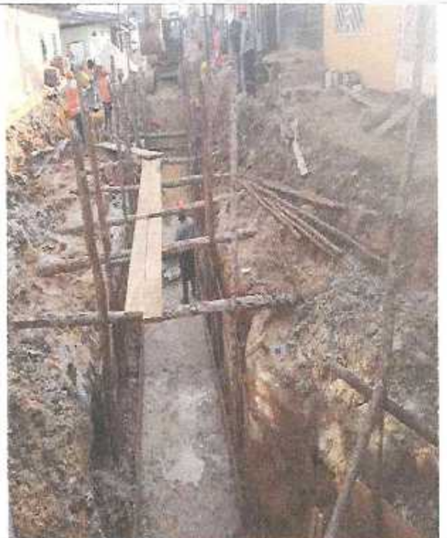
Cama de arena y llenado de solado para canal rectangular.
