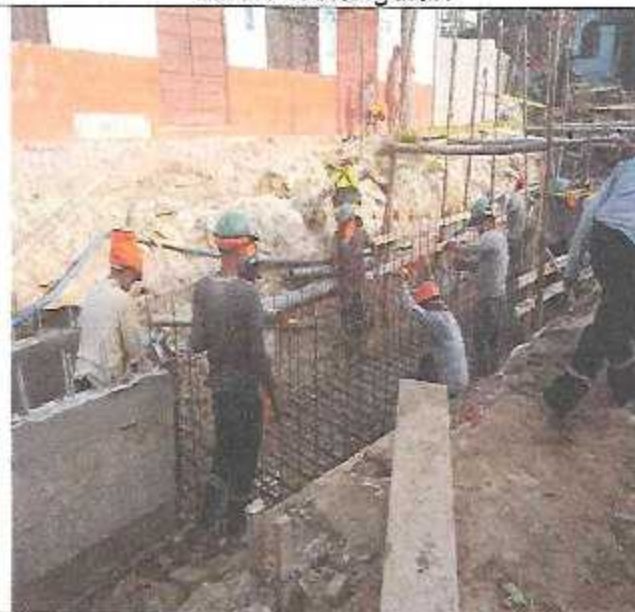
Colocación de acero corrugado para canales.
