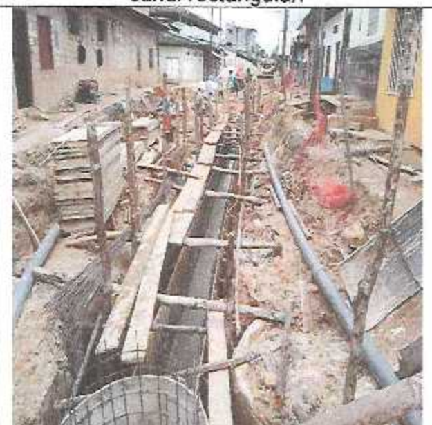
Llenado de mortero en muros de canal en calle prolongación José Gálvez.
