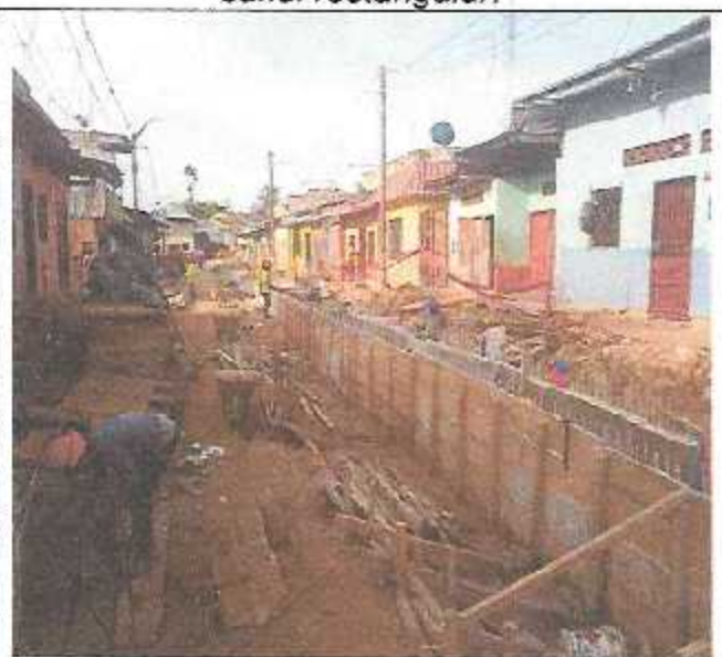
Encofrado y desencofrado de muros y losa de canal.
