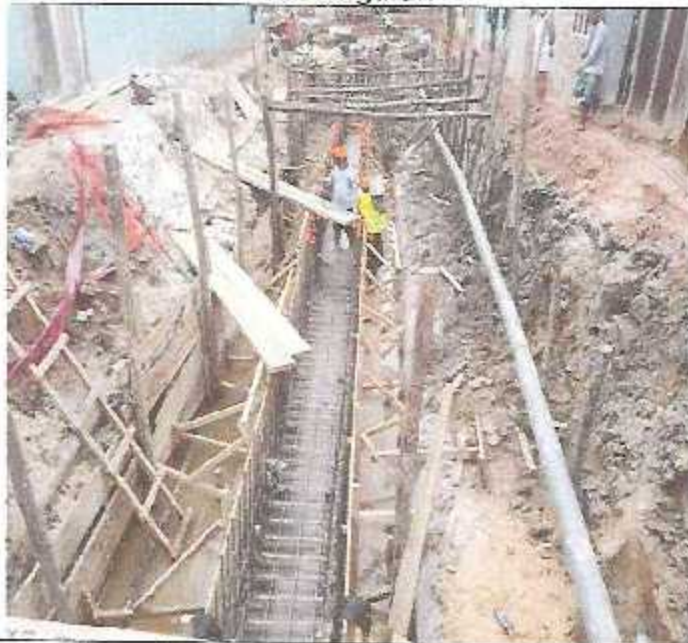
Llenado de mortero en losa de fondo de canales.
