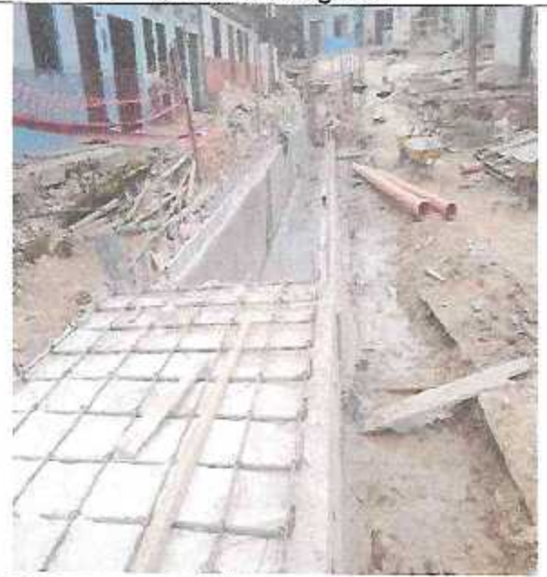
Pulido de paredes de canal.
